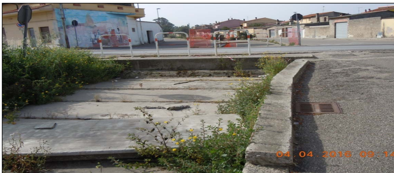
Figura 4 - Tratto tombato a monte dell'attraversamento della SP9
