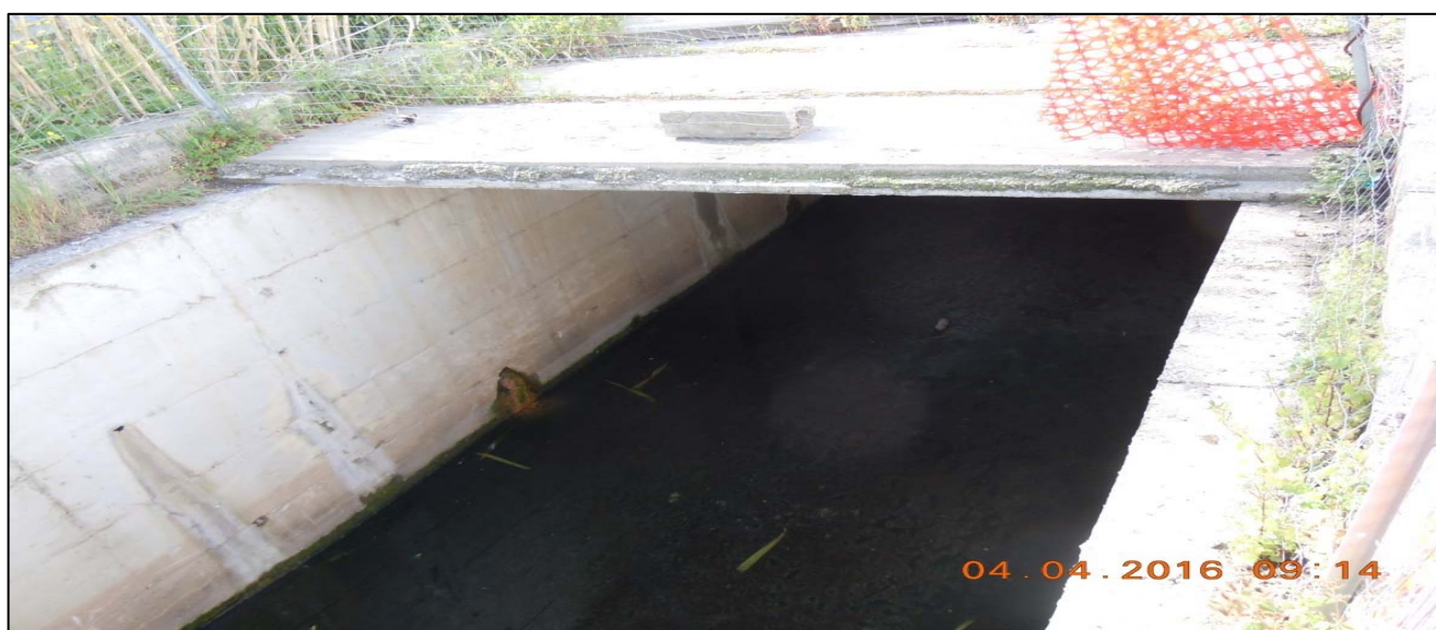
Figura 5 - Tratto a valle dell'attraversamento della SP9
